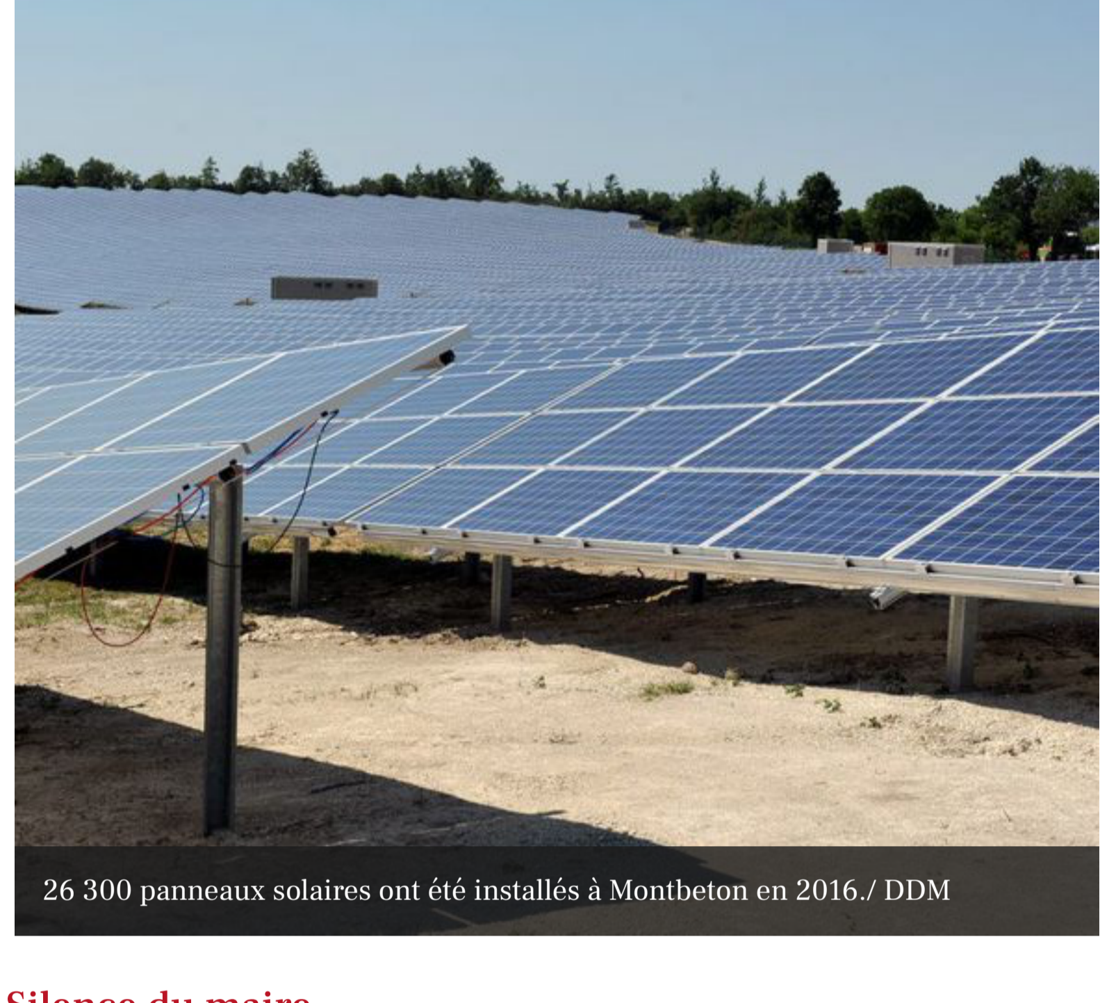
26 300 panneaux solaires ont été installés à Montbeton en 2016. / DDM
